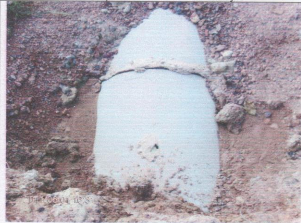
bstc de 1,00m complementar o aterro até a altura de 2,00m
