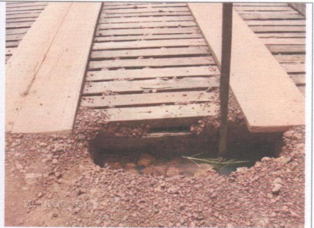
Recompor aterro nos encontros
